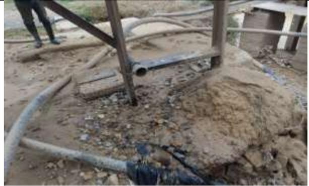
**Foto No. 10.** Manguera sin flujo debido al retiro de la misma en el punto de captación.
