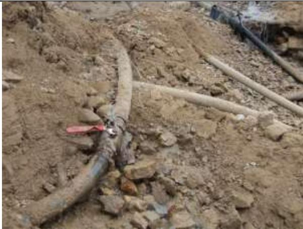
**Foto No. 7.** Apertura de la válvula de paso localizada en la planta de agregados.
